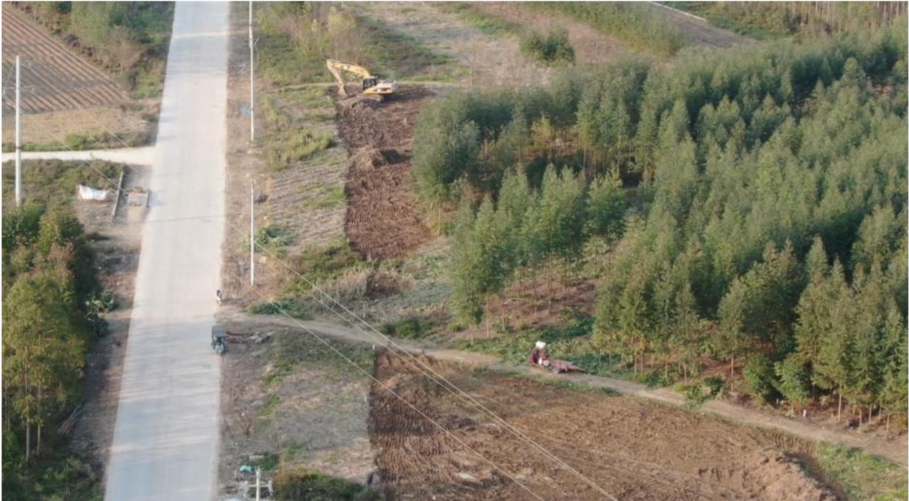
图 7 管网工程区表土剥离现状
