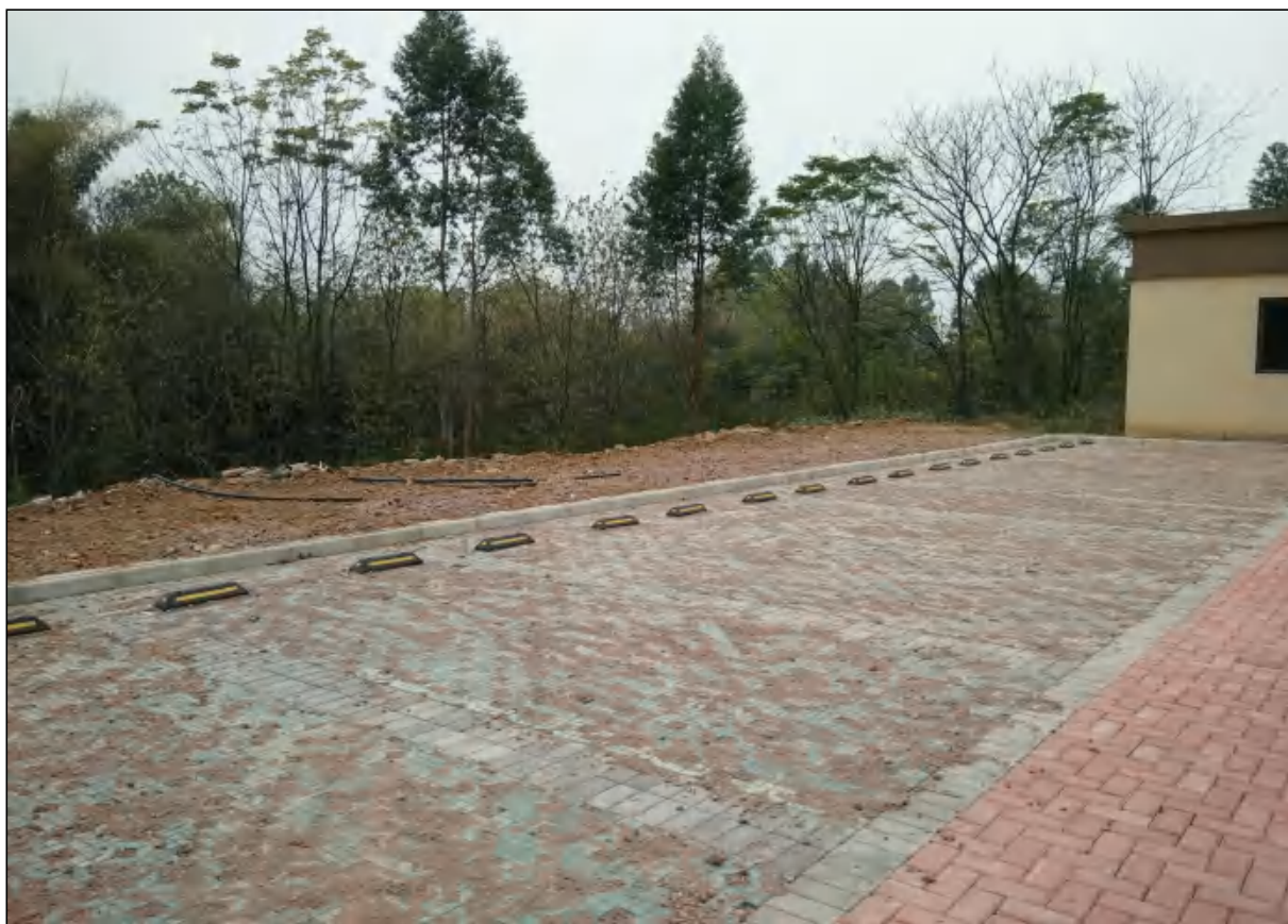
项目用地内生态停车场铺植草砖现状
