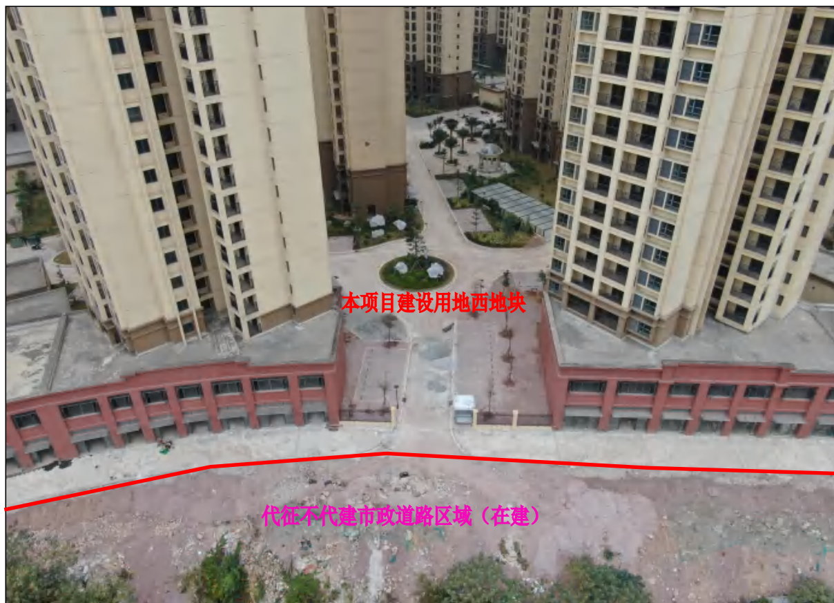
项目用地西地块东北面与北区交界处现状，现状已完成硬化铺砖，正在进行排水、道路等建设
