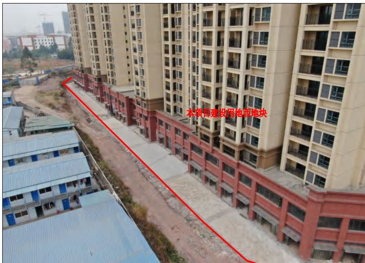
项目用地西地块东南面现状，现状进行铺砖、排水等附属设施建设
