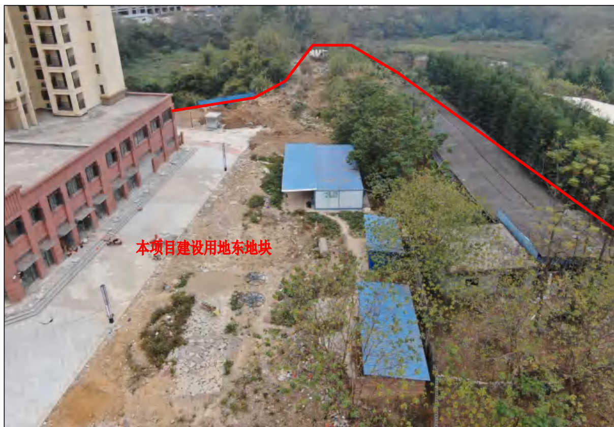
项目用地东地块东北面现状，现状进行绿化、道路、硬化铺装等附属设施建设
