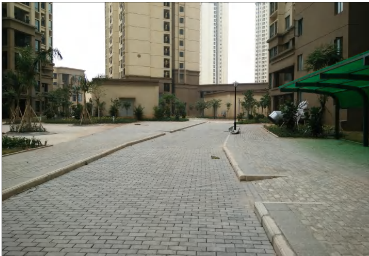
项目用地内人行道、人行步道铺透水砖现状
