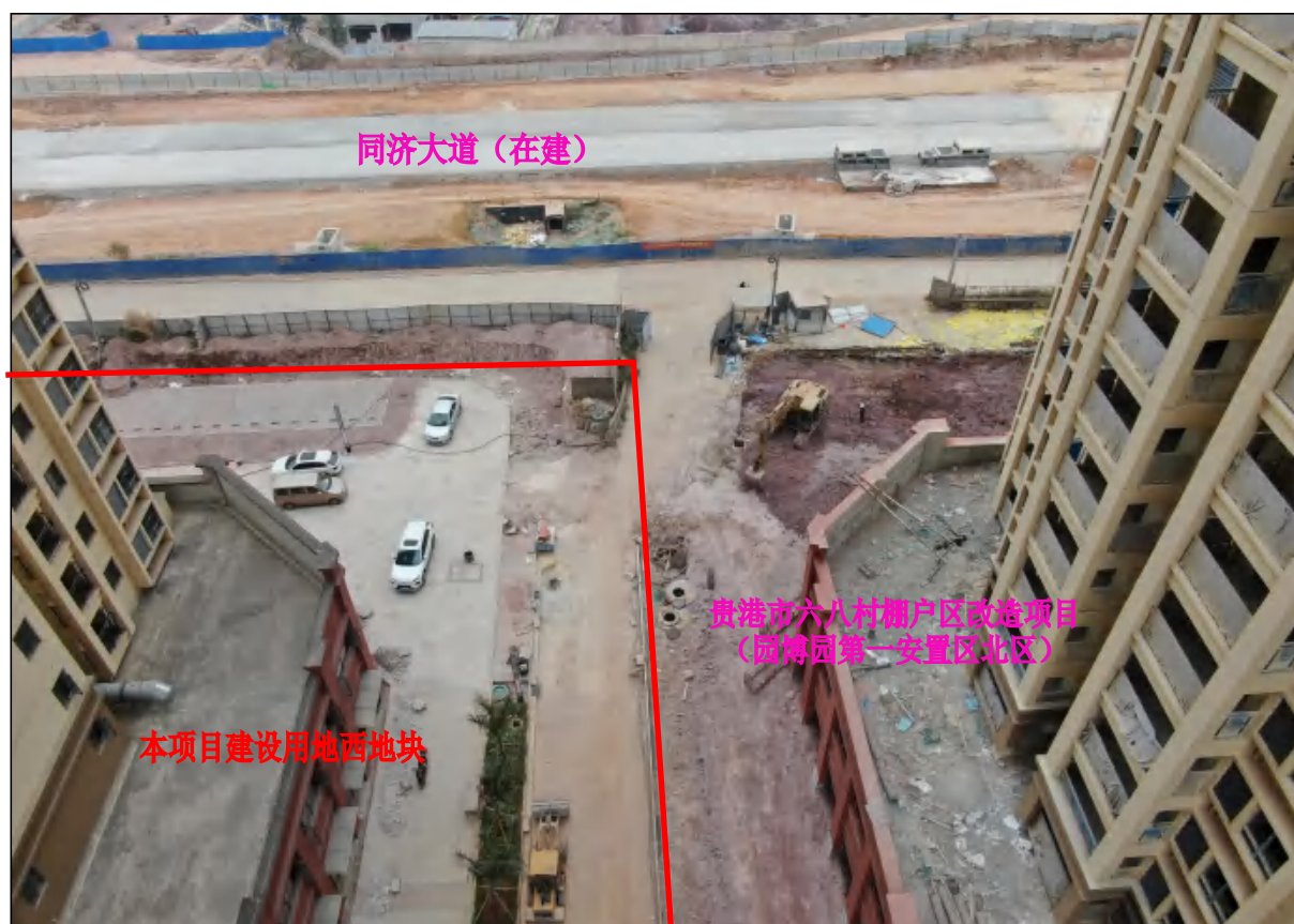
项目用地西地块东北面用地现状，现状正在进行硬化铺装工作
