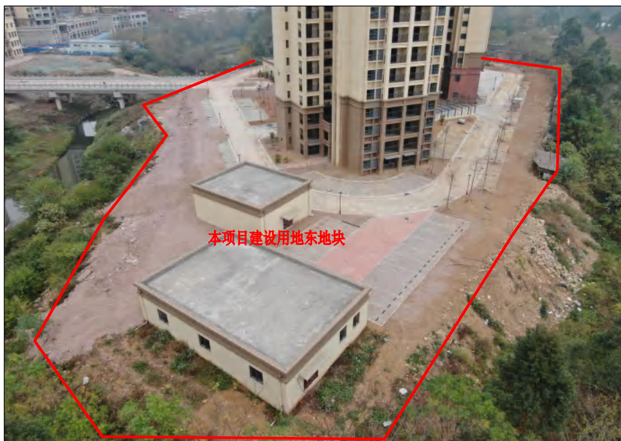
项目用地东地块现状，现状进行绿化、道路、硬化铺装等附属设施建设
