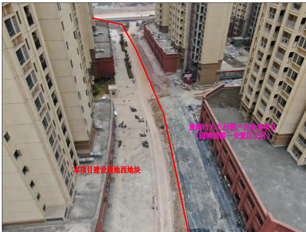
项目用地西地块北面用地现状，现状正在进行硬化铺装工作
