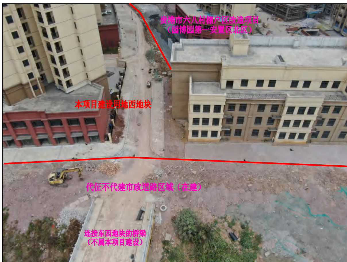
项目用地西地块东北面用地现状，现状进行地面铺装工程
