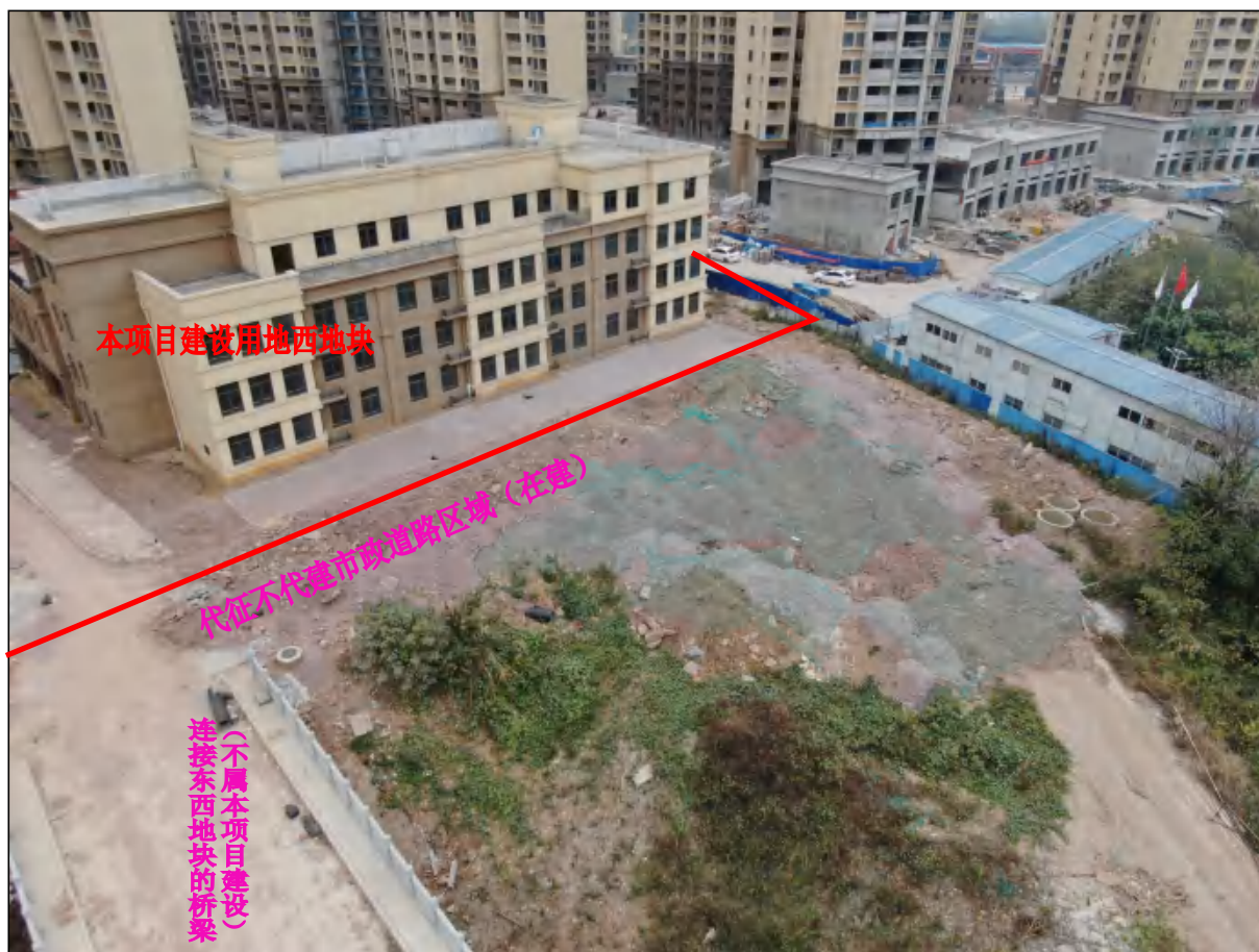
项目用地西地块东北面现状，现状正在进行铺砖工程
