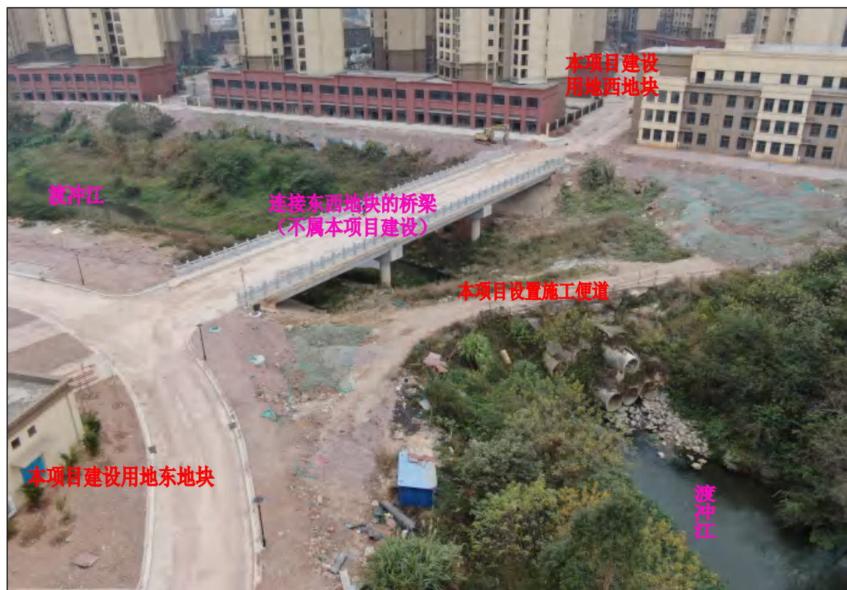
连接东西地块的桥梁现状 (已建成), 本项目设置施工便道用地现状
