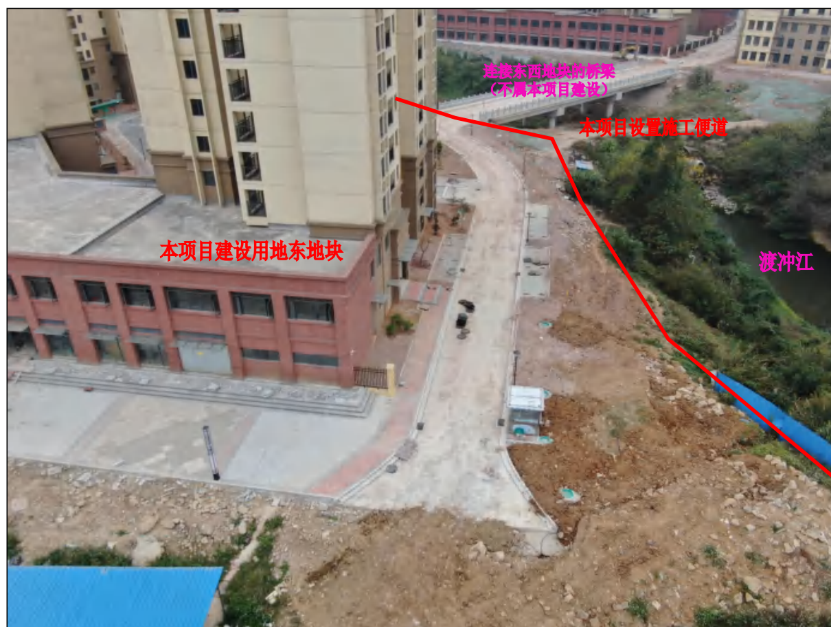
项目用地东地块北面现状，现状进行绿化、道路、硬化铺装等附属设施建设
