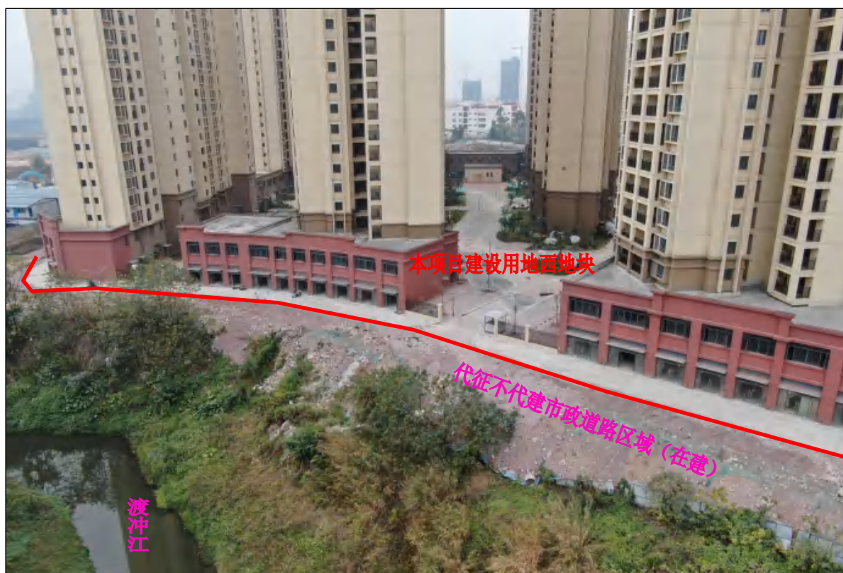
项目用地西地块东面紧邻渡冲江用地现状，地面已完成硬化铺装工作
