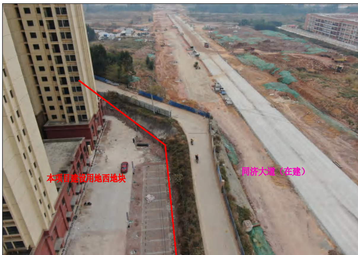
项目用地西地块东南面现状，现状进行绿化、道路、硬化铺装等附属设施建设
