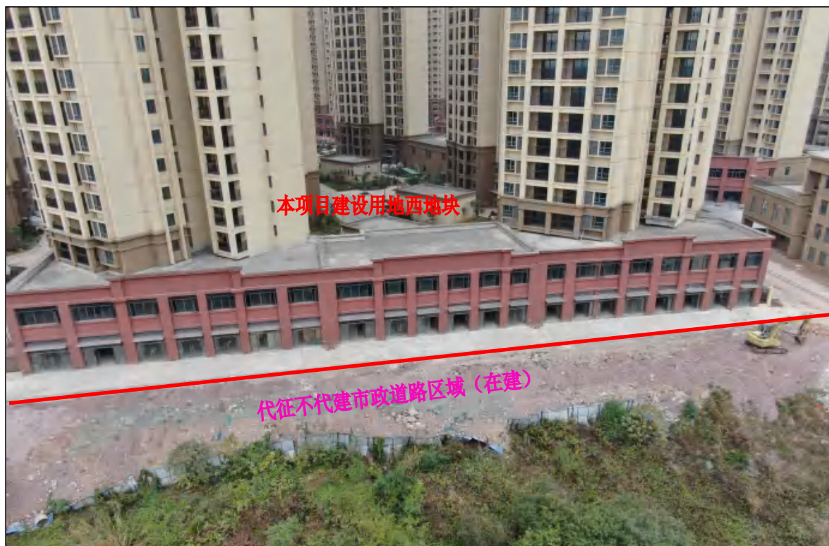
项目用地西地块东北面与北区交界处现状，现状已完成硬化铺砖，正在进行排水、道路等建设
