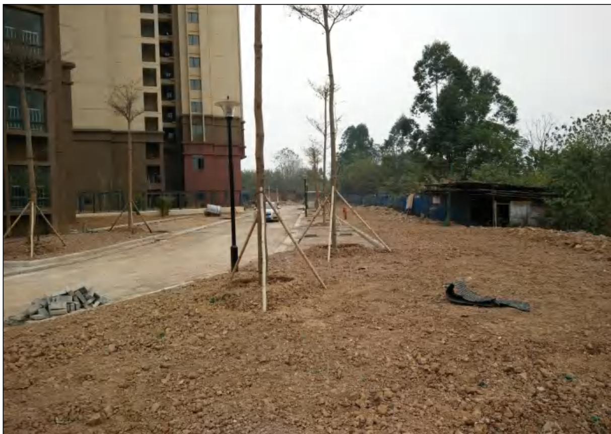
项目用地西地块用地内堆料场现状，建议遇降雨及时做好临时覆盖措施
