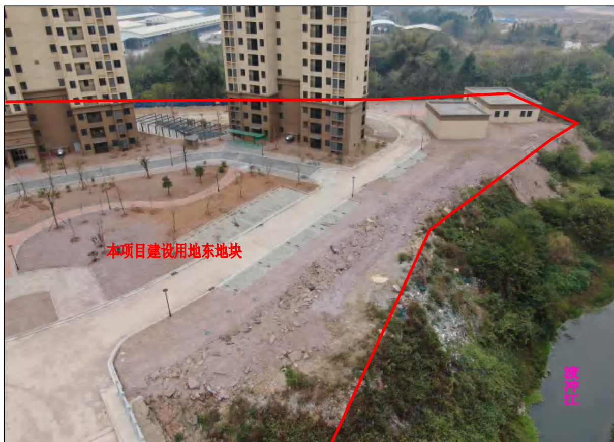
项目用地东地块西面现状，现状进行绿化、道路、硬化铺装等附属设施建设
