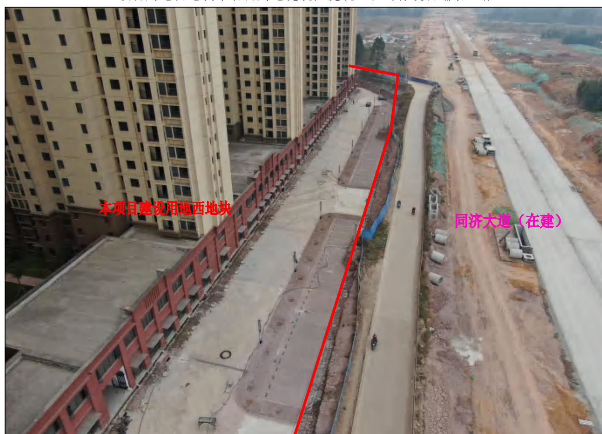
项目用地西面紧邻在建同济大道现状，现状进行绿化、道路、硬化铺装等附属设施建设
