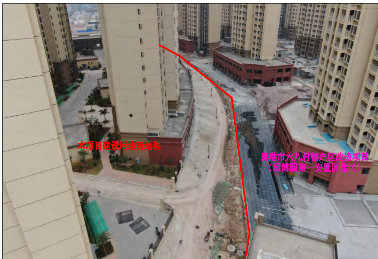
项目用地西地块北面用地现状，现状正在进行硬化铺装工作
