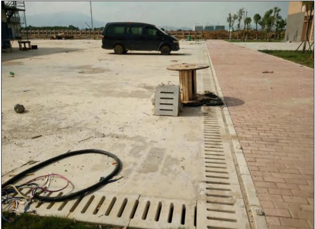
本项目用地北面排水沟现状，设施完善，运行状况较好
