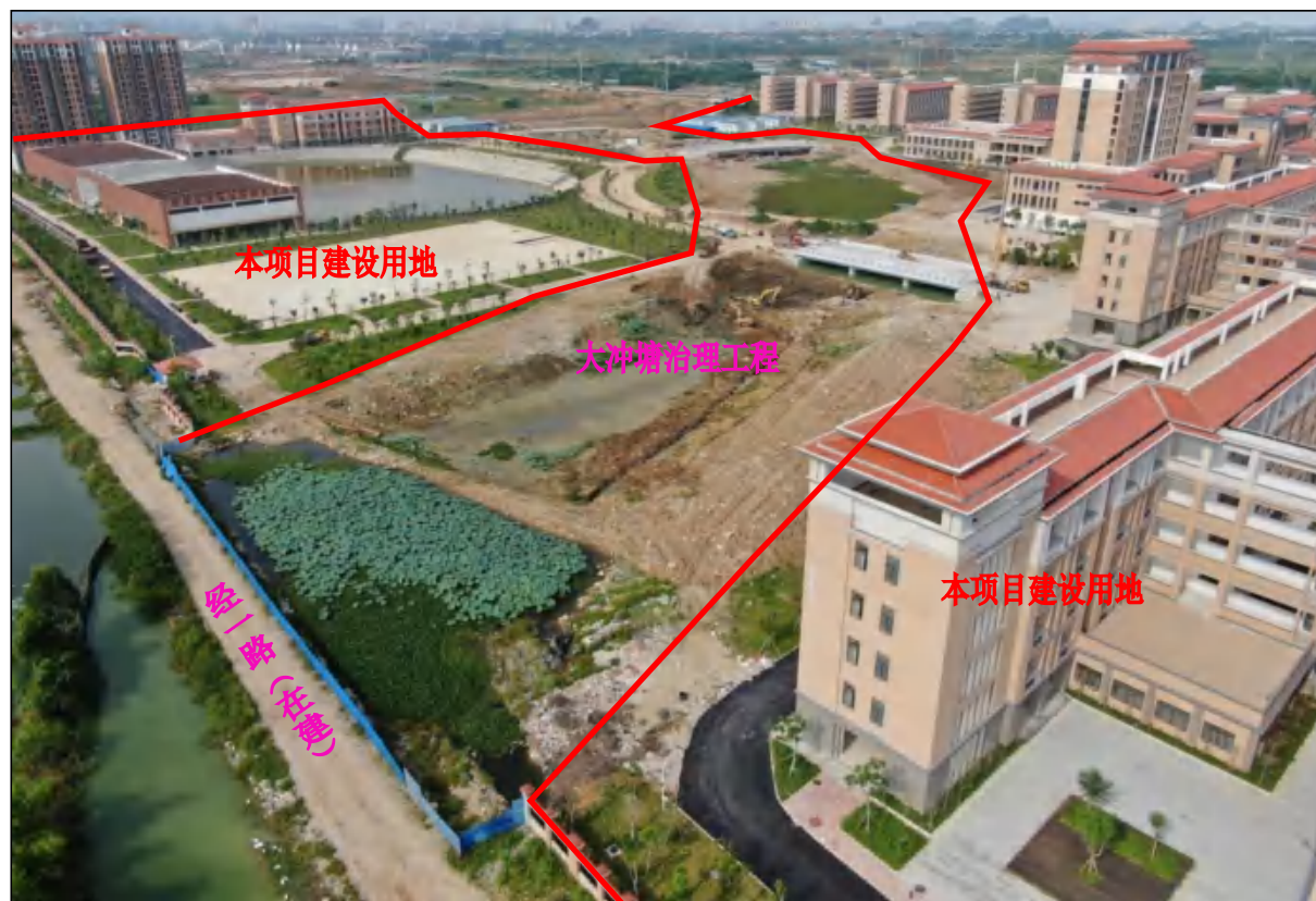
项目用地西面现状，穿过本项目用地的大冲塘治理工程正在施工，本项目的桥梁工程正在建设
