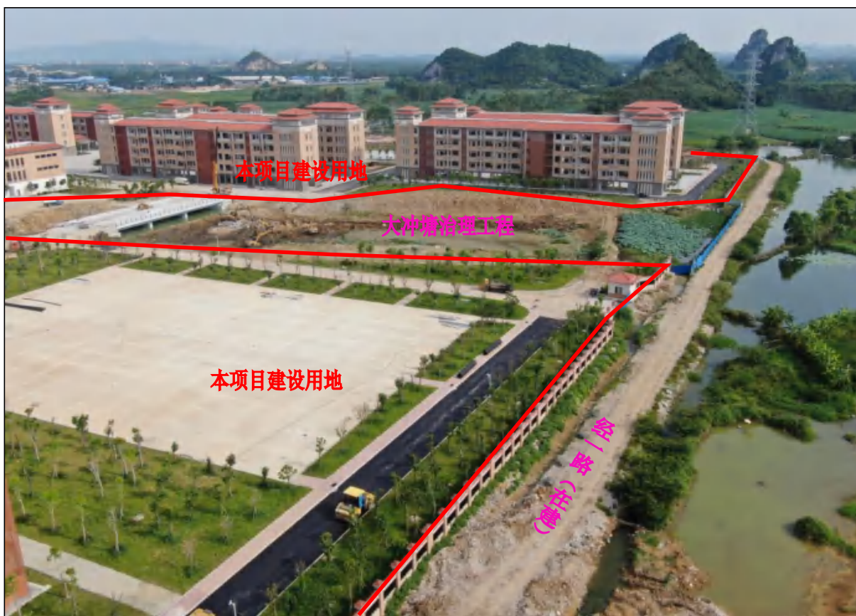
项目用地西北面现状，主体建筑、附属设施等已建成，植被生长状况良好
