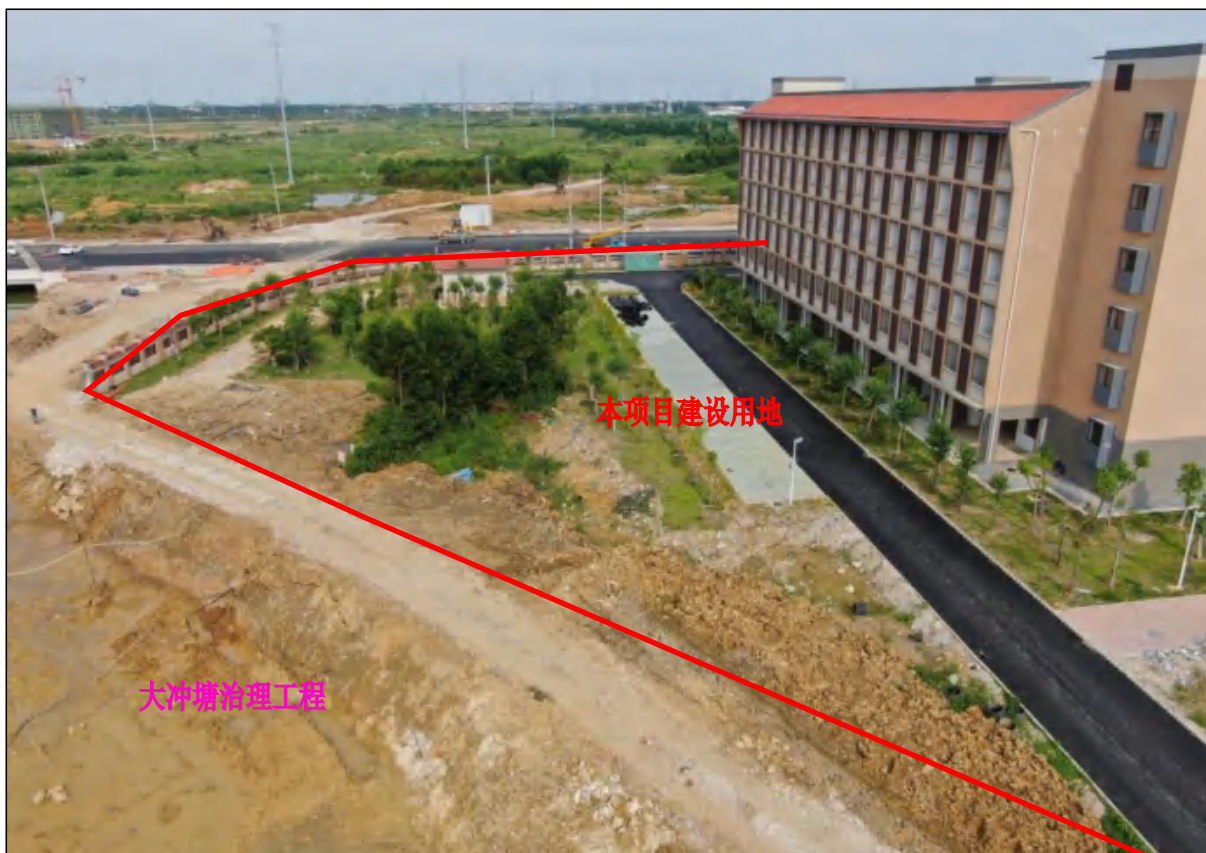
本项目用地东北面现状，地面裸露，景观绿化、铺砖等尚未施工完成
