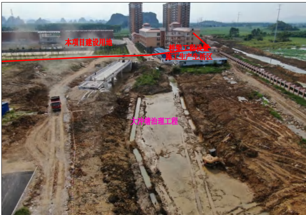
穿过本项目用地的大冲塘治理工程东段北面施工现状，本项目桥梁工程建设现状，裸露面积较大
