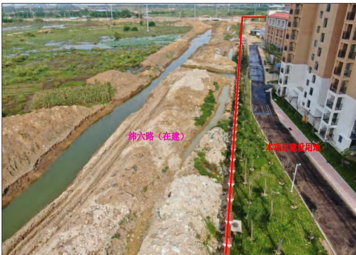
项目用地北面现状，主体建筑、附属设施等已建成
