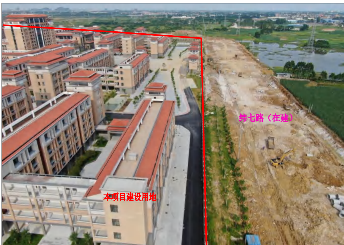
项目用地南面现状，主体建筑、附属设施等已建成
