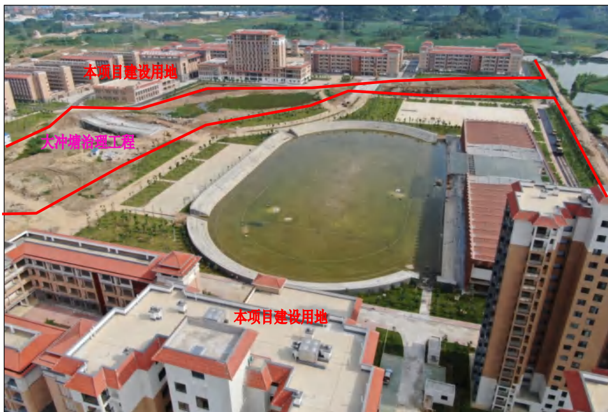
项目用地北面现状，主体建筑、附属设施等已建成
