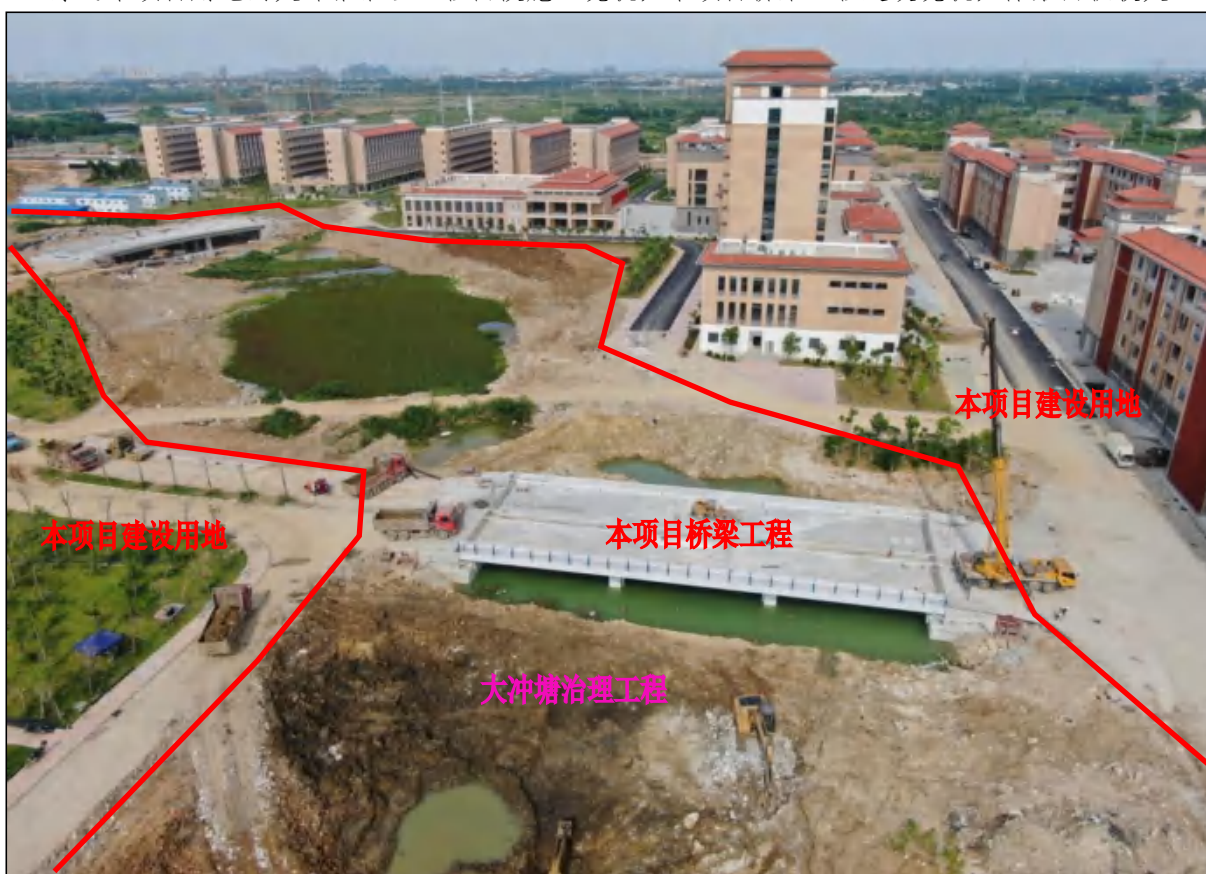
穿过本项目用地的大冲塘治理工程中段施工现状，本项目桥梁工程建设现状，裸露面积较大
