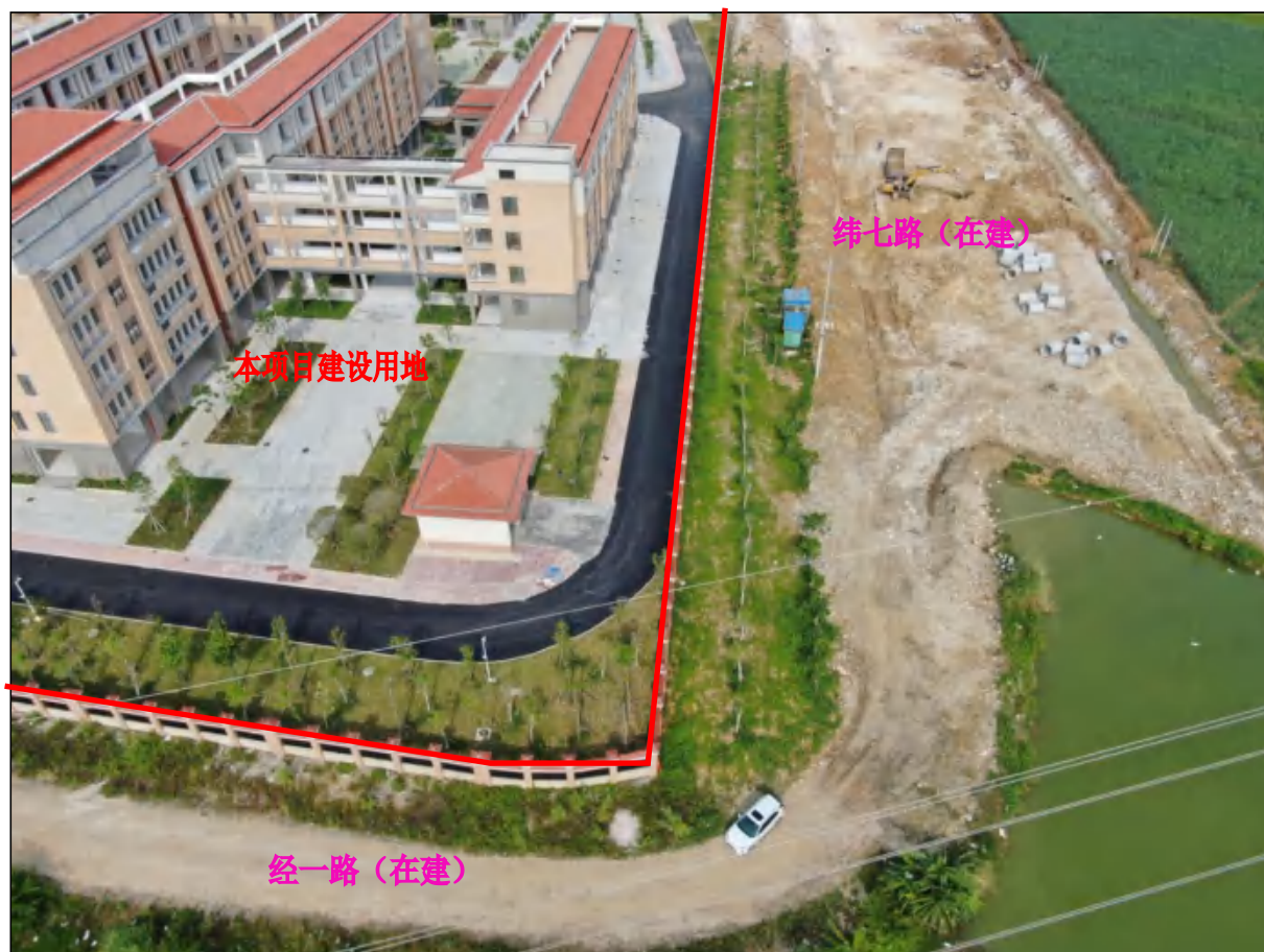
项目用地西南面现状，主体建筑、附属设施等已建成
