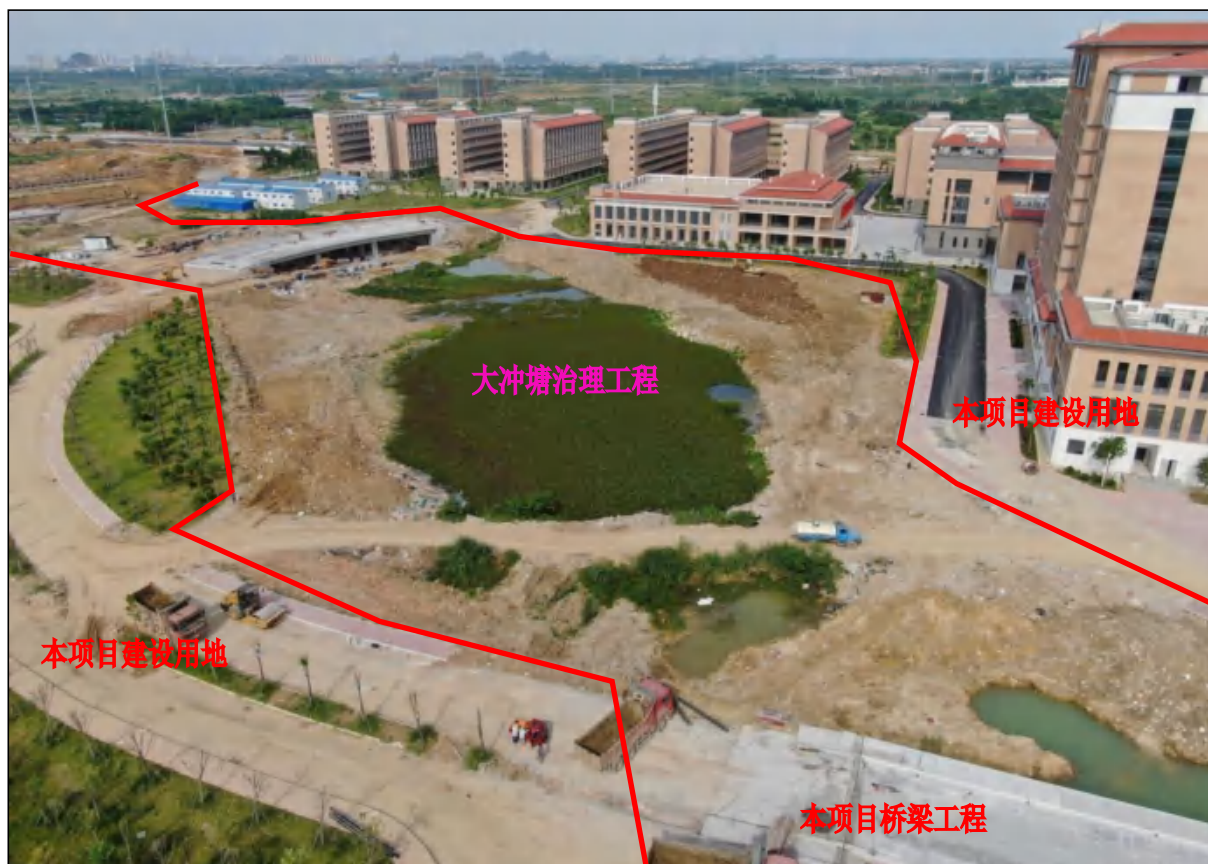
穿过本项目用地的大冲塘治理工程中段施工现状，本项目桥梁工程建设现状，裸露面积较大
