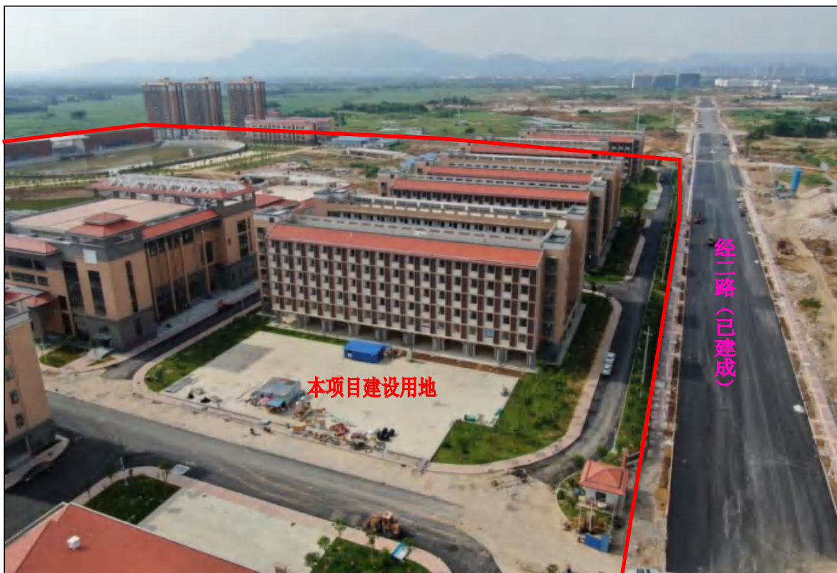
项目用地东面现状，主体建筑、附属设施等已建成
