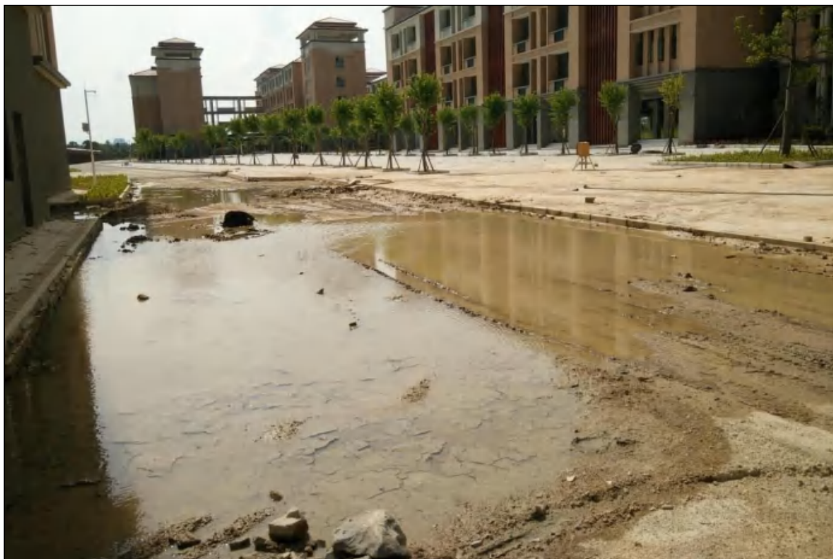
项目用地内南面校区大门因纬七路市政排水设施尚未建成，造成雨水淤积的现象
