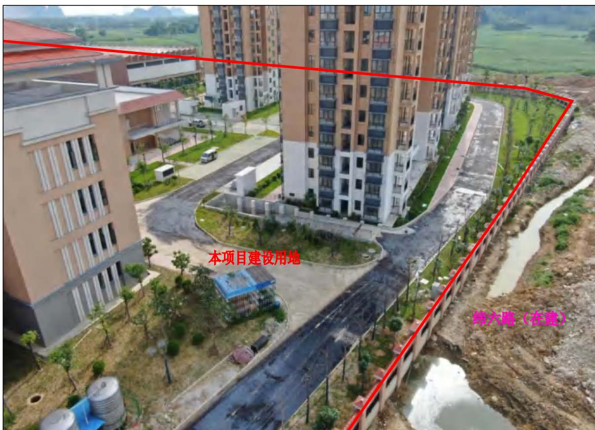
项目用地北面现状，主体建筑、附属设施等已建成
