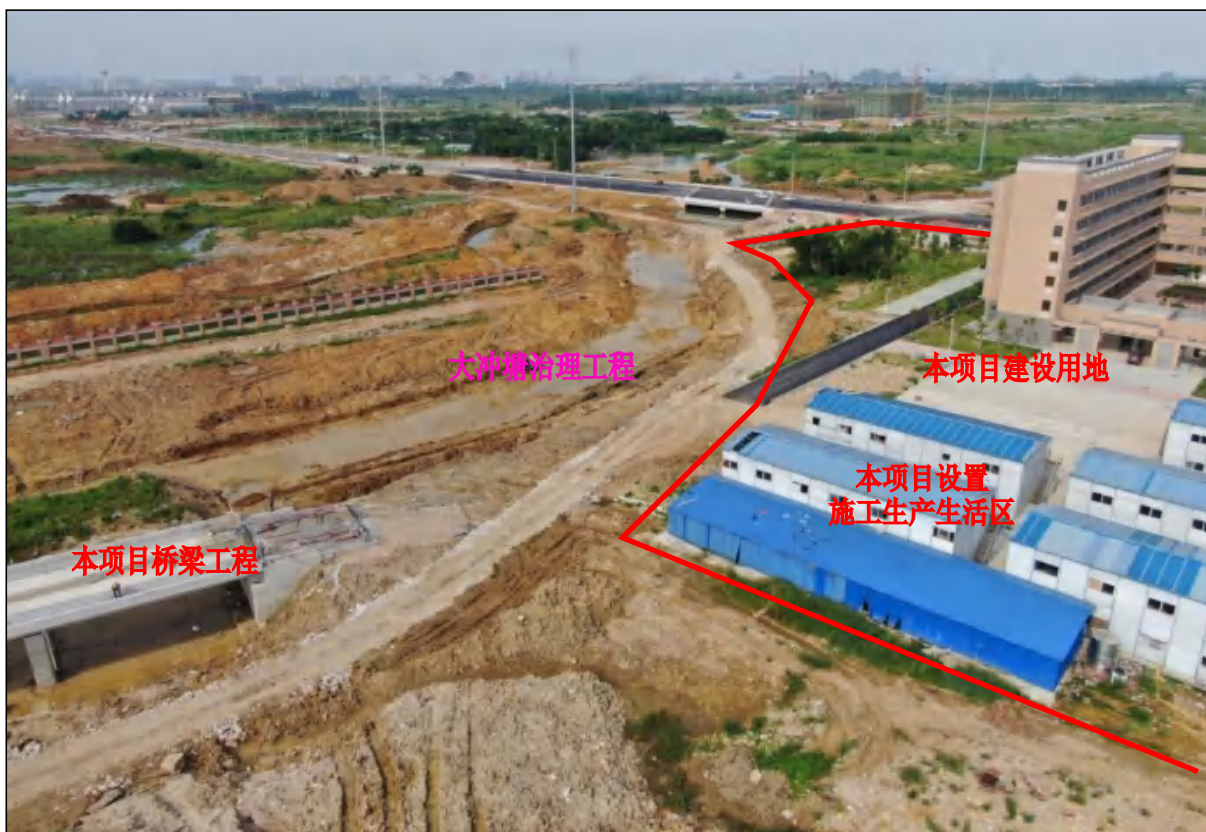
穿过本项目用地的大冲塘治理工程东段施工现状，本项目桥梁工程建设现状，裸露面积较大
