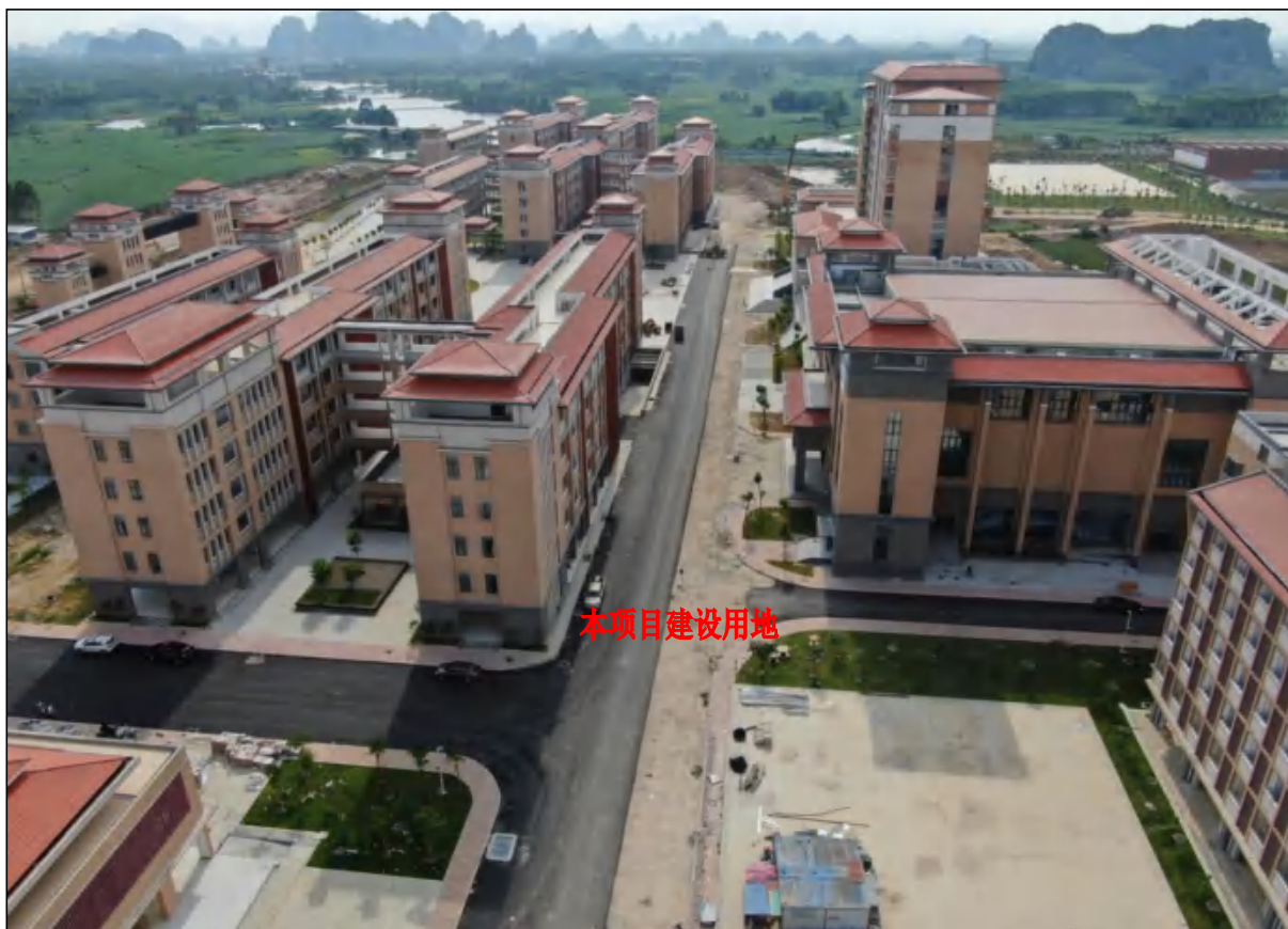
项目用地东南面现状，主体建筑、附属设施等已建成
