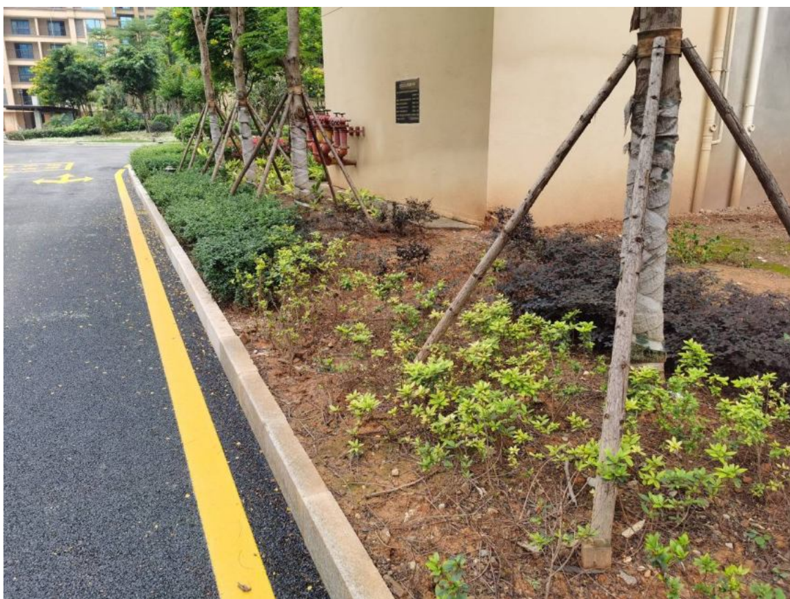
5号楼西面植被生长情况近景图(部分植被枯死)
