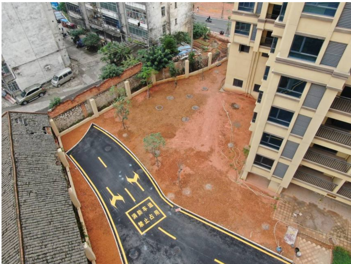
1号楼西面区域监测记录图片(未实施景观绿化, 裸露状态)
