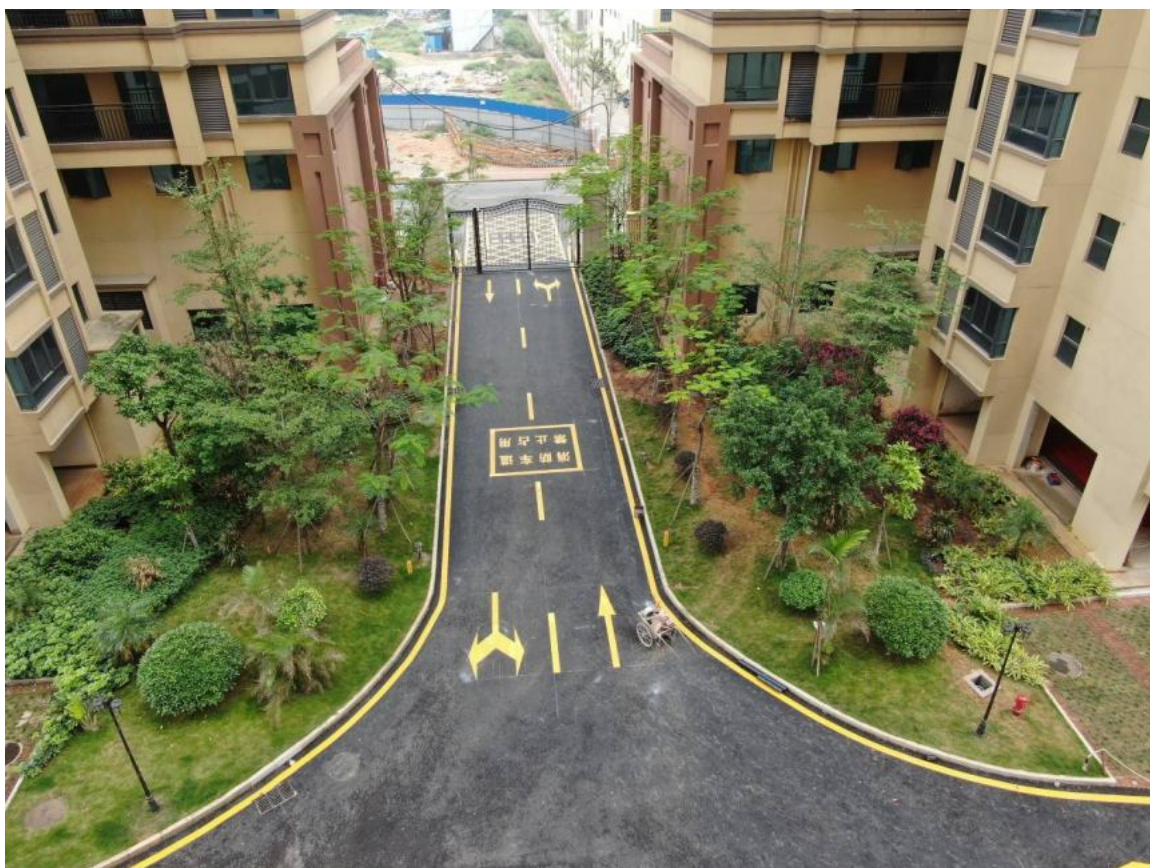
1号楼与2号楼之间区域监测记录图片
