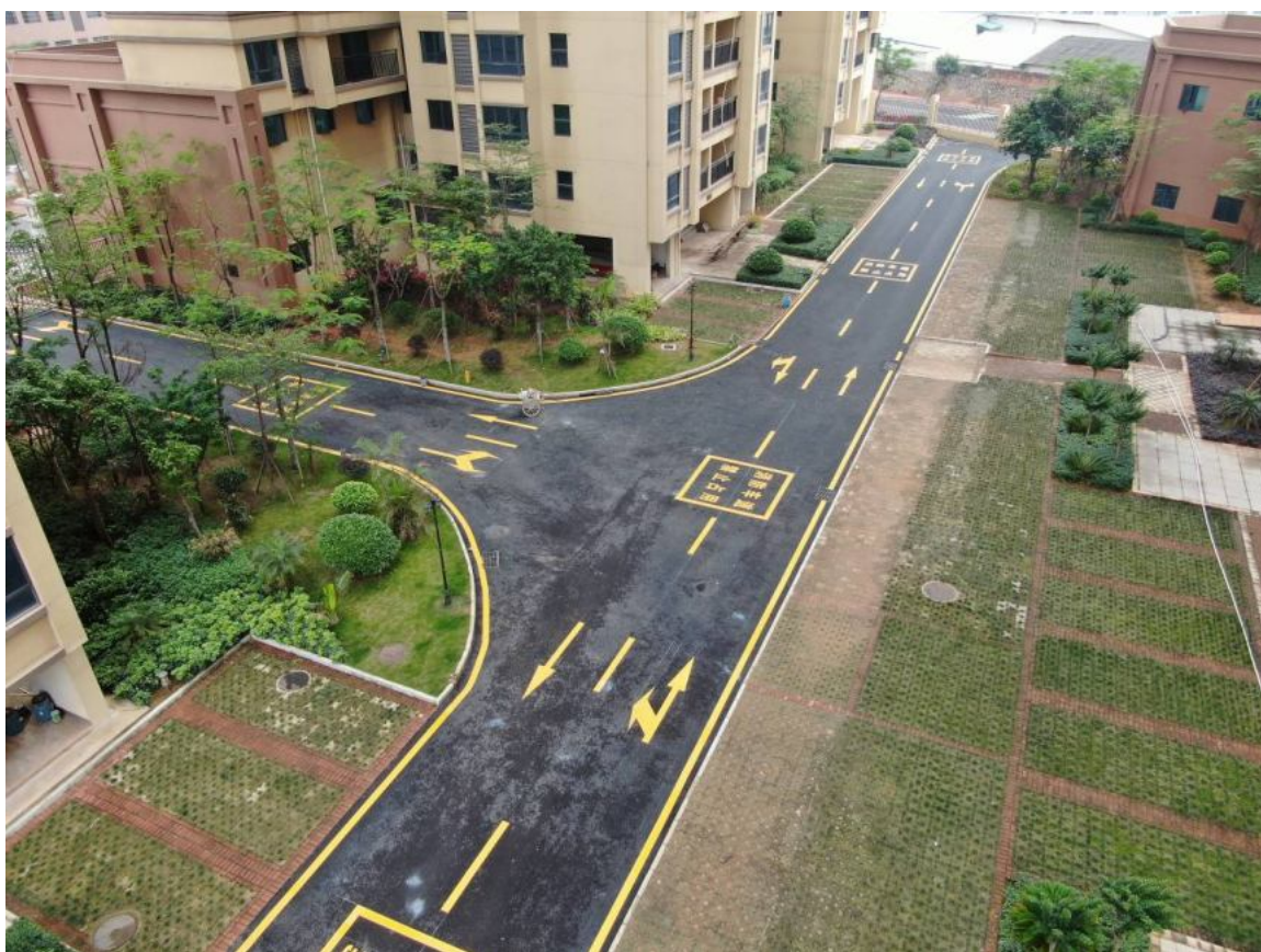
1号楼、2号楼与3号楼之间区域生态停车场及雨水工程监测记录图片
