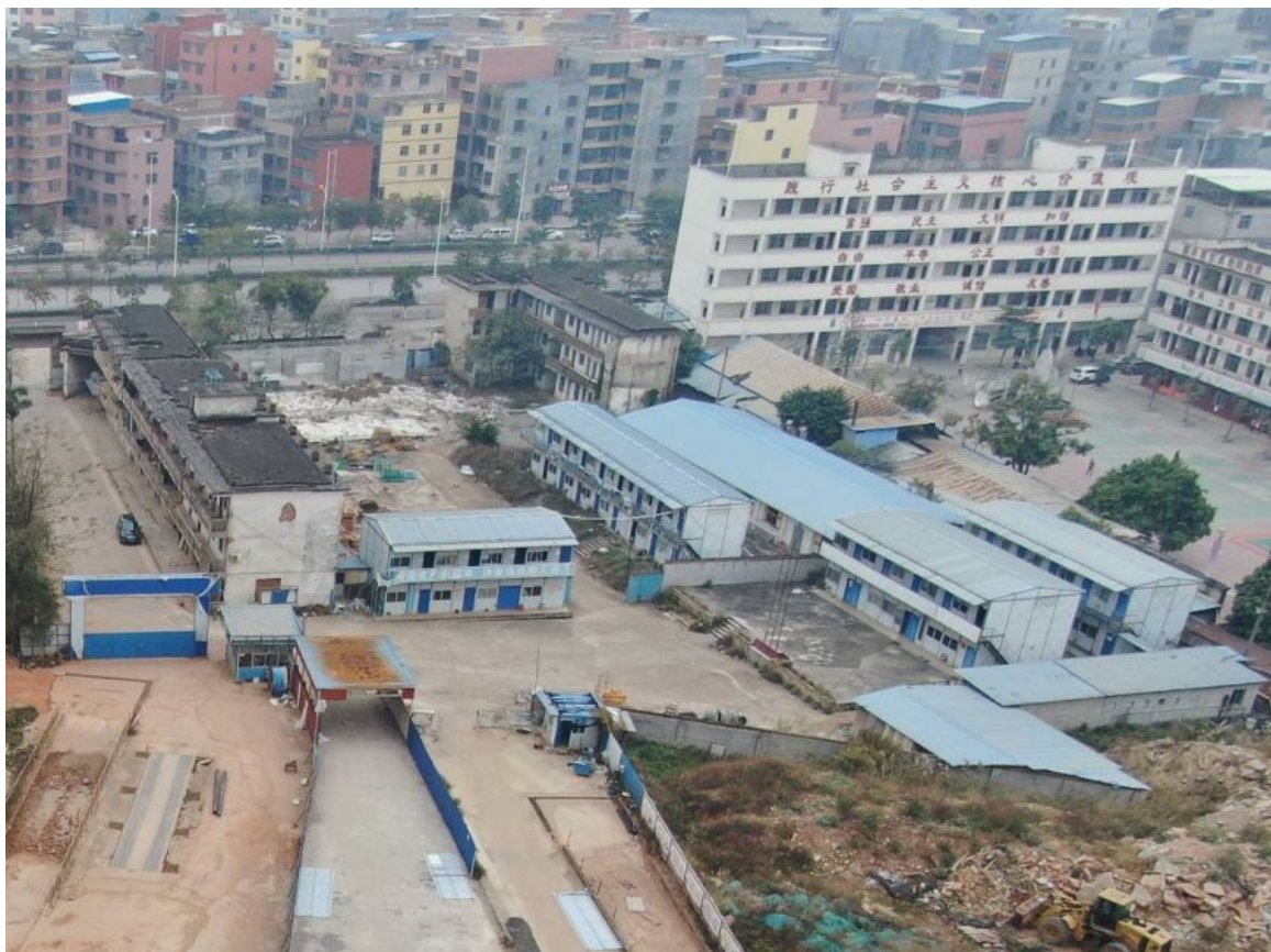
施工生产生活区板房区域监测记录图片
