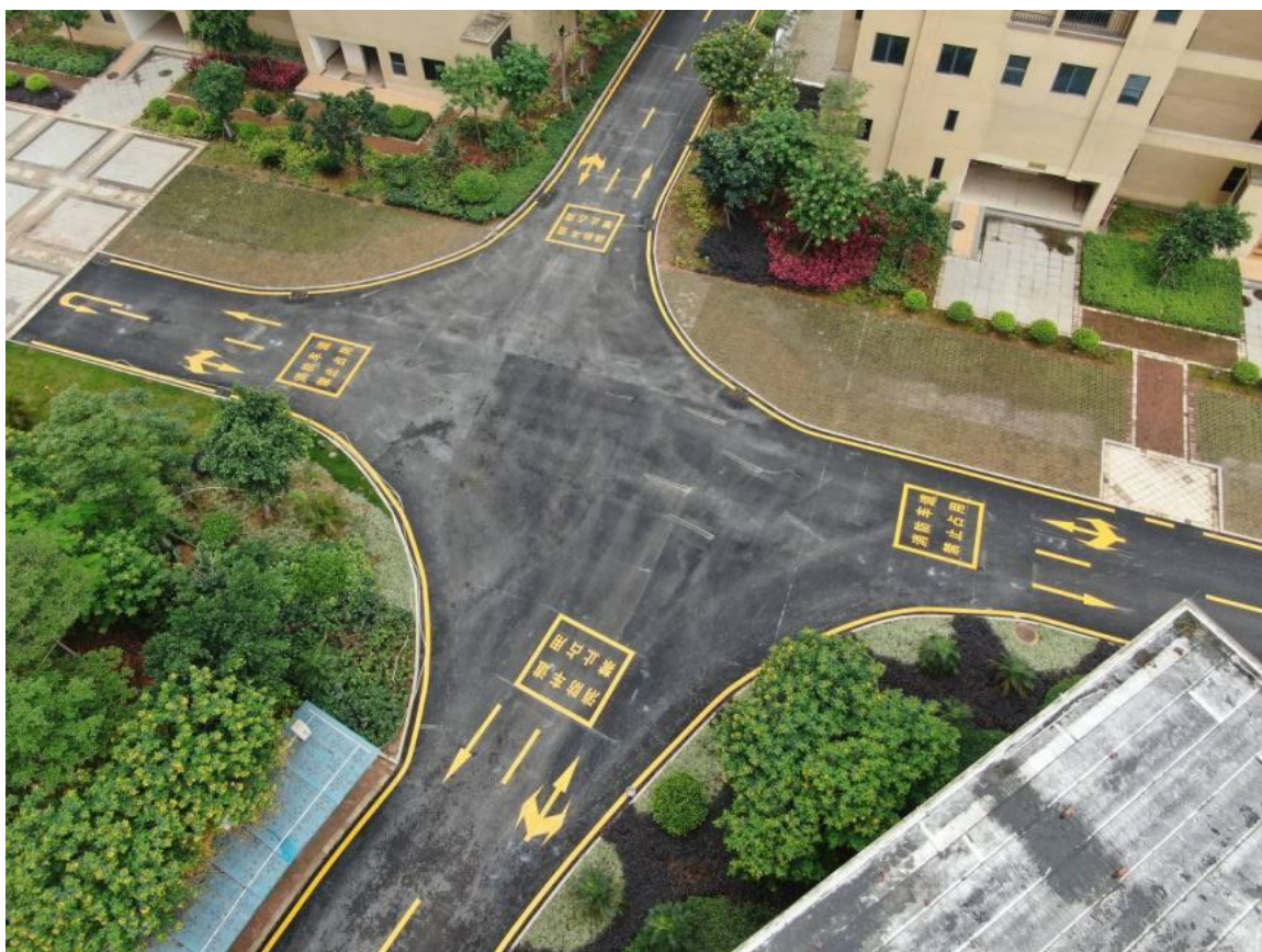
3号楼与4号楼、5号楼之间区域生态停车场及雨水工程监测记录图片
