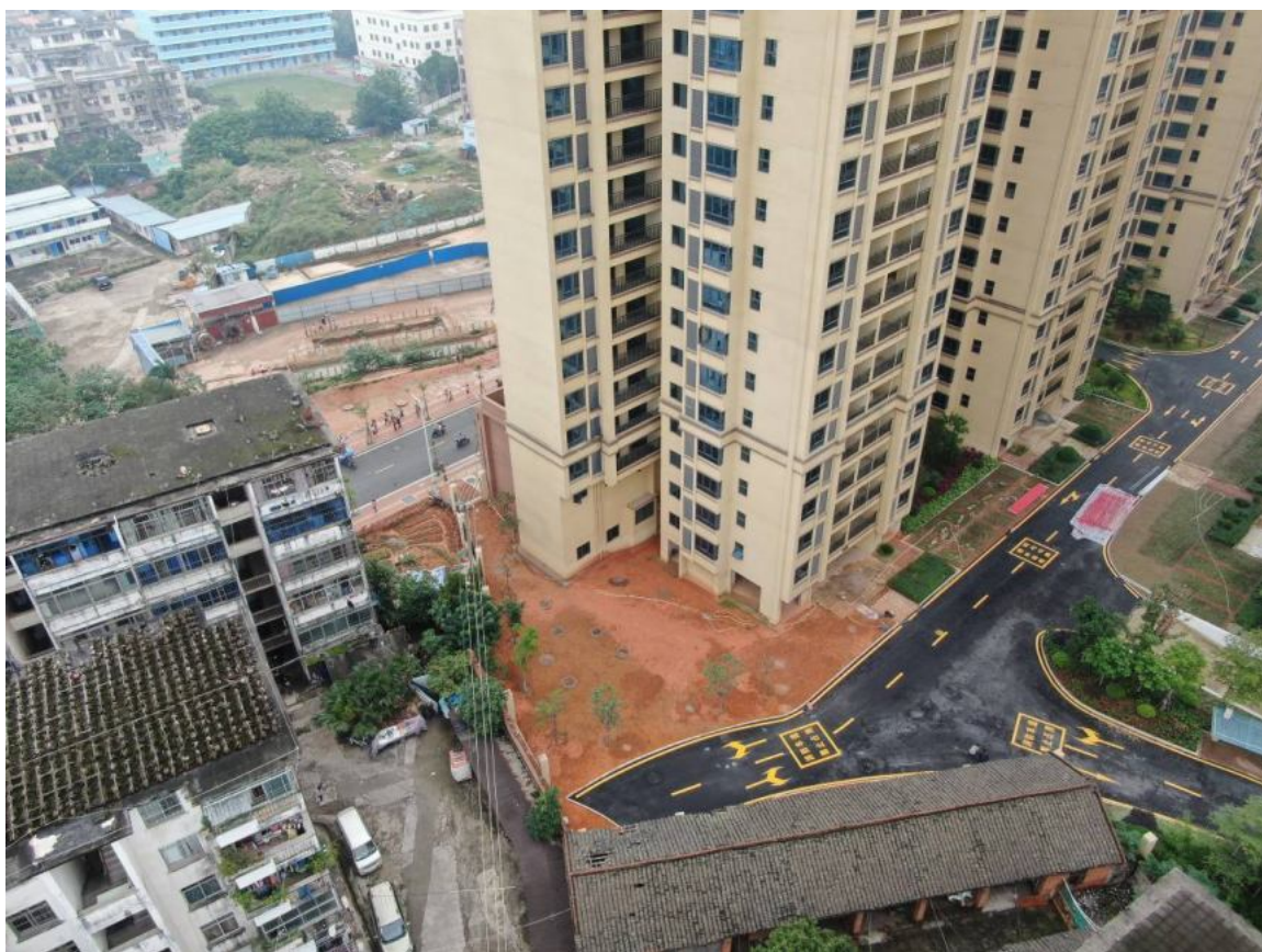
项目用地西北角西南角监测记录图片
