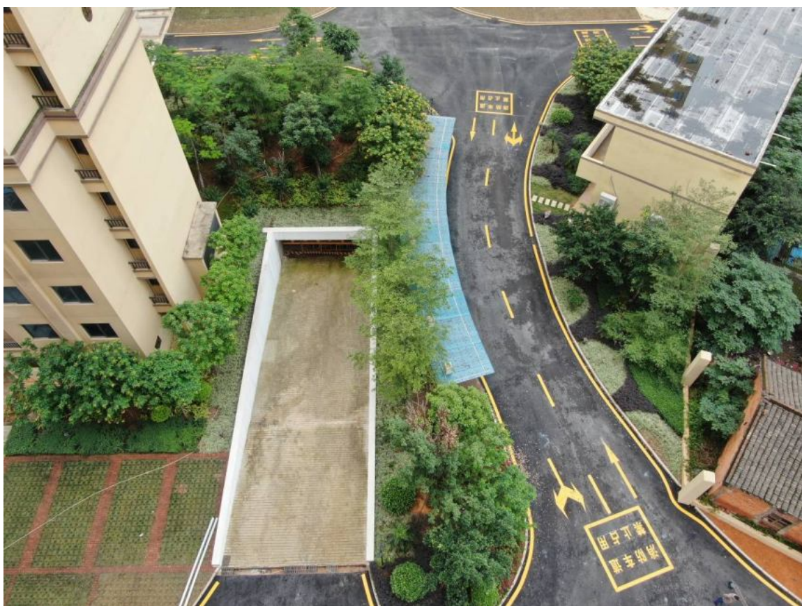
3号楼西面区域监测记录图片
