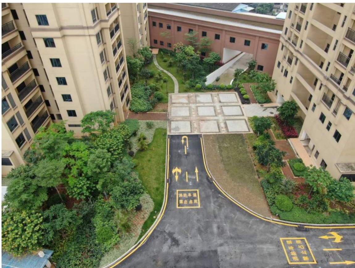
3号楼与5号楼之间区域监测记录图片
