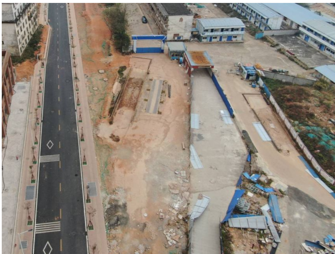
施工生产生活区施工进出口区域监测记录图片
